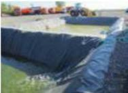
Wasseraufbereitung beim Baulos Flughafen Wien/Schwechat (Einfräsen von Querrillen auf der Landebahn 16/34 zur Verbesserung des Aquaplaningverhaltens der Piste): Für die Aufbereitung des Schmutzwassers wurden zwei große Becken gegraben. Das größere mit ca. 350 m³ Fassungsvermögen diente dabei für die Aufnahme des Schmutzwassers und das kleinere mit ca. 300 m3 für das aufbereitete und für die Wiederverwendung bestimmte Sauberwasser
